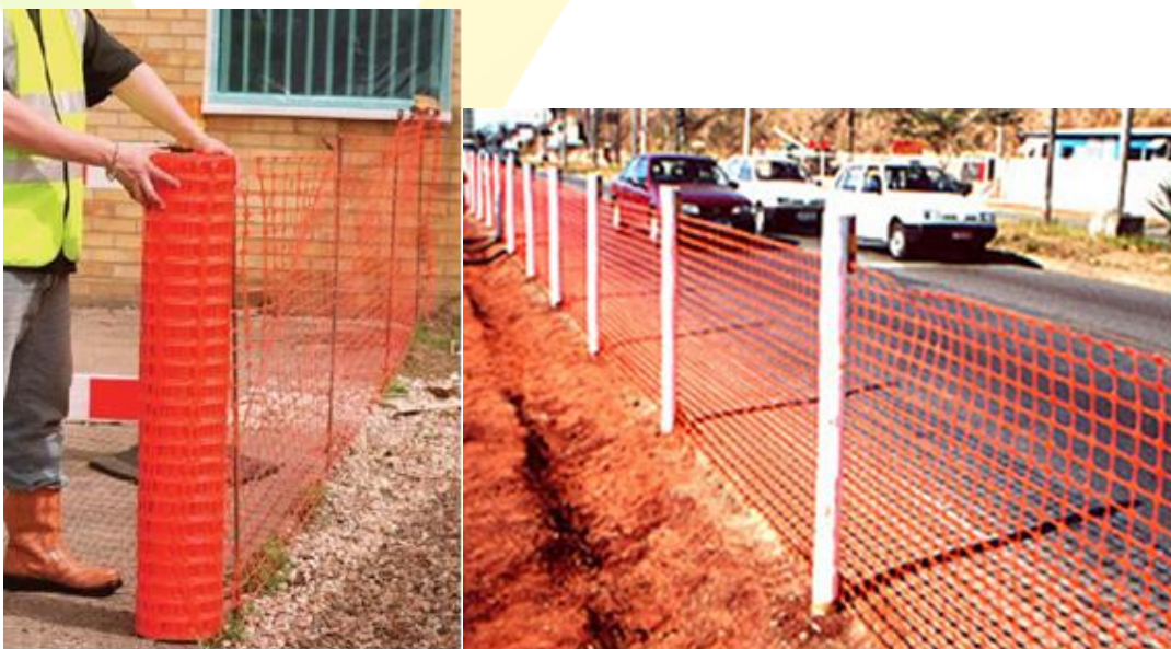
Figura 02: Isolamento com tela tapume em polietileno
